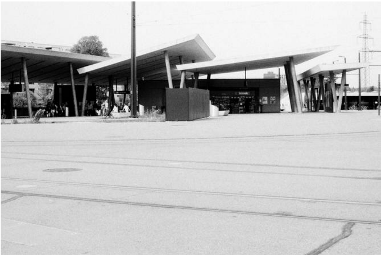
Bahnhof Stettbach, Endpunkt der ersten Etappe.
