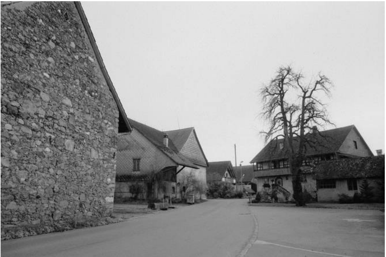
Fast wie in Frankreich: Natursteinmauer, unverputzt.
